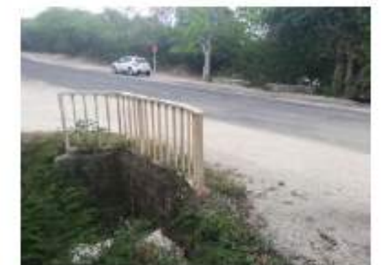
PR 4+900, ouvrage hydraulique
