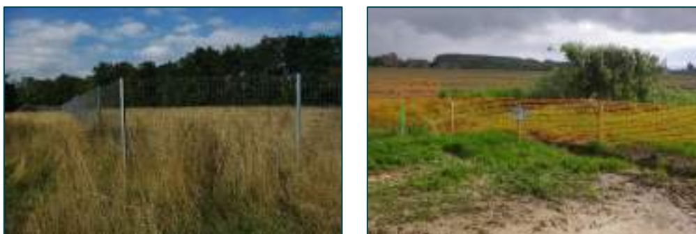
Figure 87 : Différents types de balisages de zones sensibles en bordure des emprises à mettre en place avant les travaux. © Biotope
