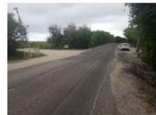
PR 4+900, ouvrage hydraulique et intersection
