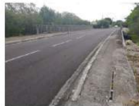
Pont sur la ravine Kabouanne, vue en direction de la Pointe-des-Châteaux
