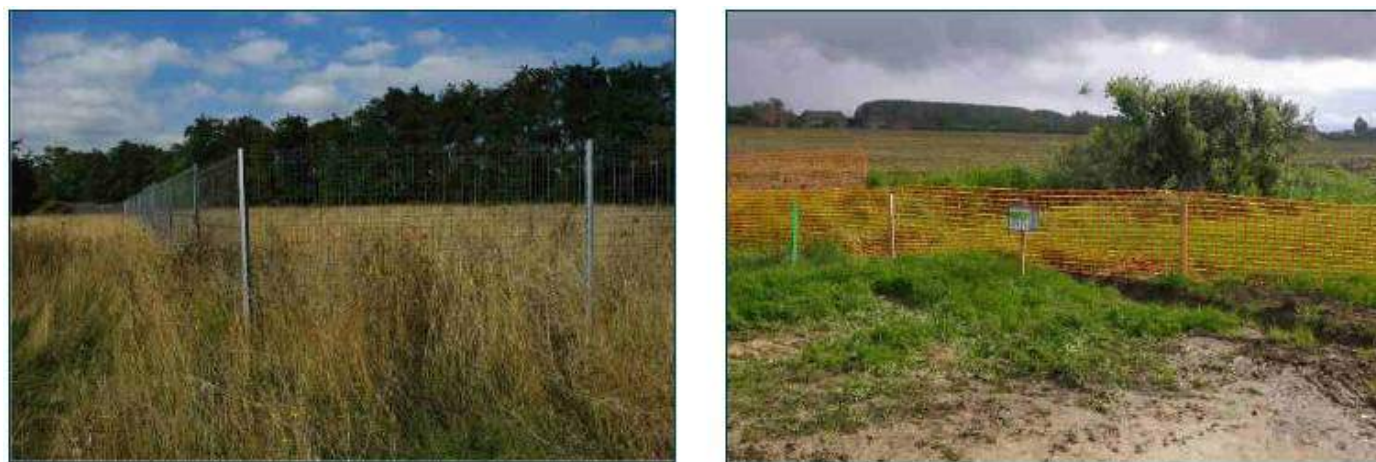
Figure 126 : Différents types de balisages de zones sensibles en bordure des emprises à mettre en place avant les travaux
